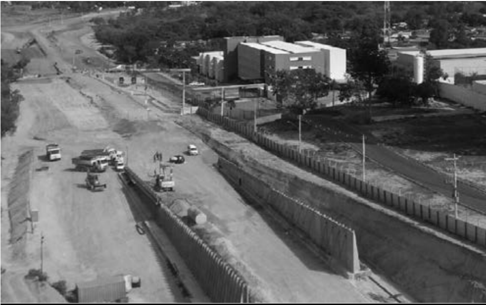
A interdição é necessária para o avanço das escavações
