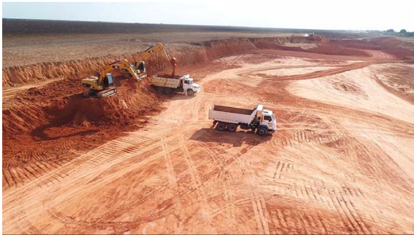
A obra está sendo realizada com recursos próprios e até o momento aproximadamente R$ 1,4 milhão já foram investidos
