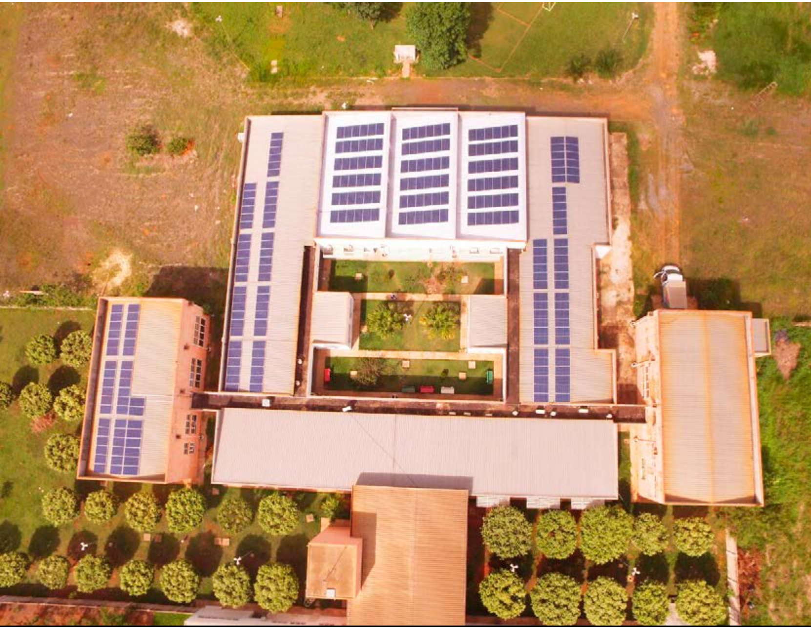
Além de investimento de energia solar, IFMT realizou reforma em parte do telhado
