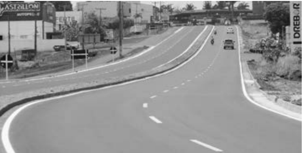
Falta de iluminação pode ter provocado o acidente
