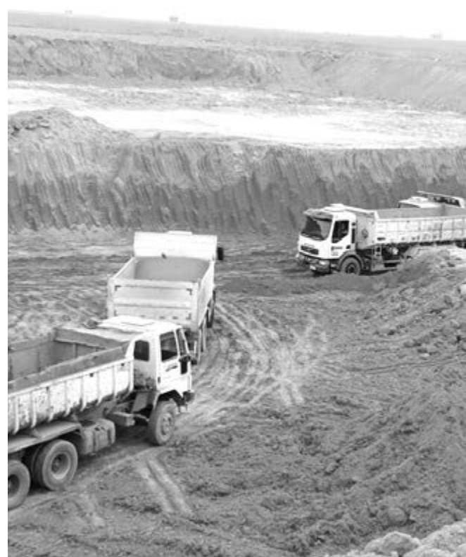
A segunda etapa será a continuação da escavação do local
