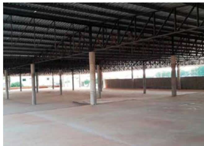
Feirantes estão ansiosos para nova estrutura ser liberada para o trabalho
