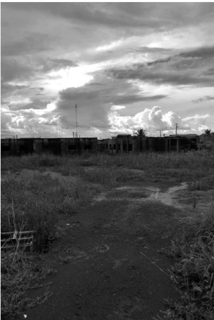
Obras estão paralisadas
