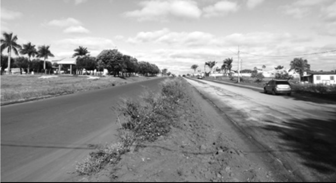
Após liberação da segunda via, Sinfra inicia trabalho de meio-fio e sarjeta
