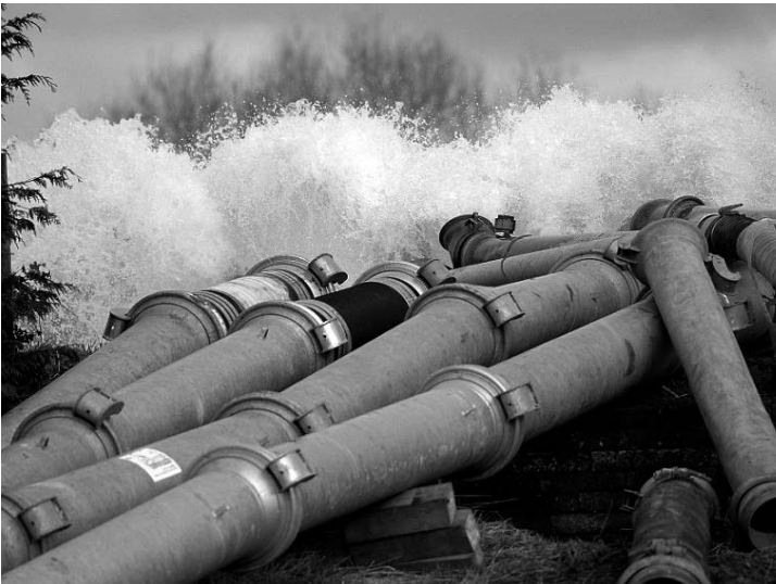
A água poderá ser retirada com bombas
