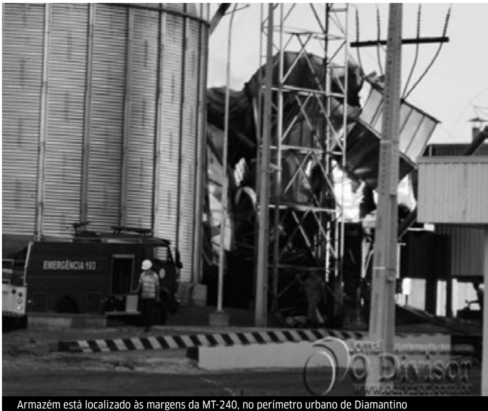
Armazém está localizado às margens da MT-240, no perímetro urbano de Diamantino
