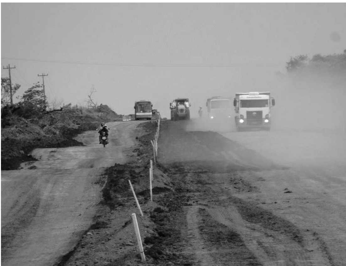
Masson quer pressa na pavimentação da MT-339 e defende sistemas multimodais de transporte
