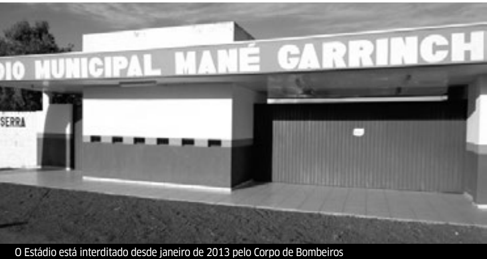
O Estádio está interditado desde janeiro de 2013 pelo Corpo de Bombeiros
