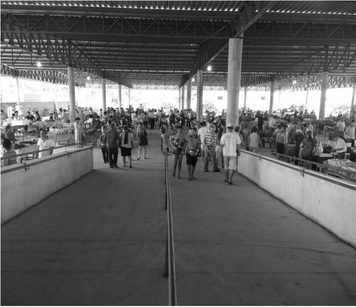
Estrutura inacabada está sendo usada através de um TAC
