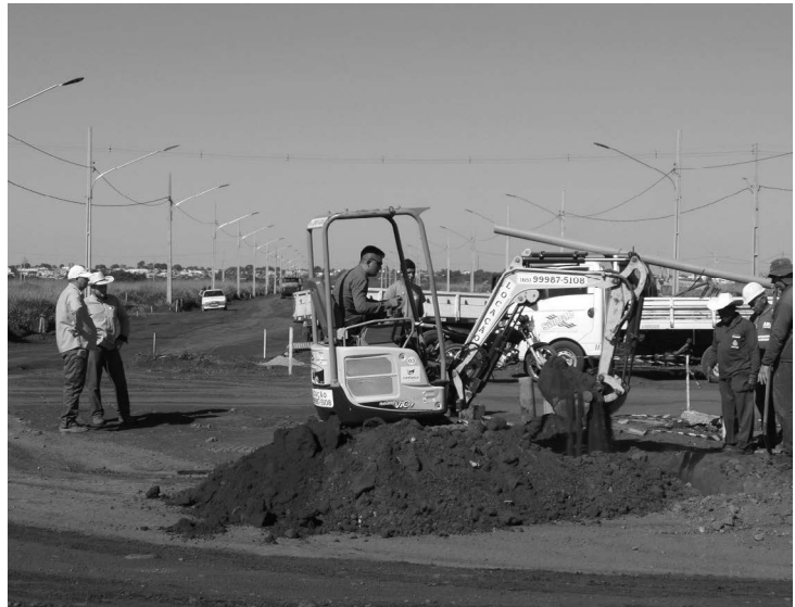
Trabalhos de ligação de água são realizados pelo Samae
