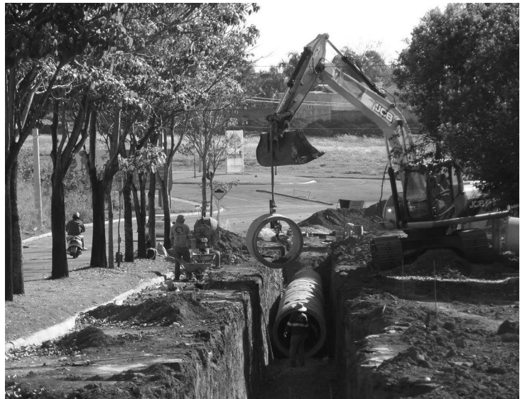
Obras resolverão antigo problema
