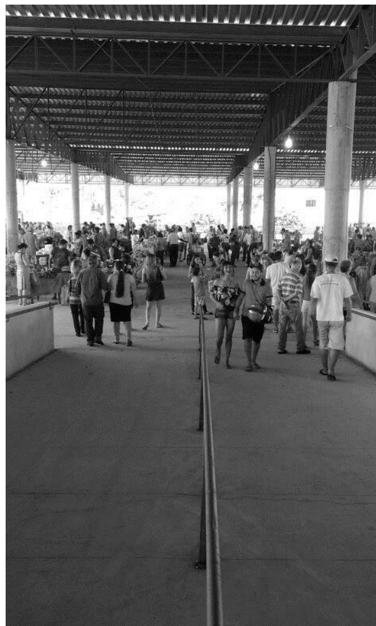
Nova etapa de obras dará ainda mais condições de uso
