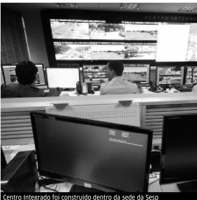
Centro Integrado foi construído dentro da sede da Sesp
