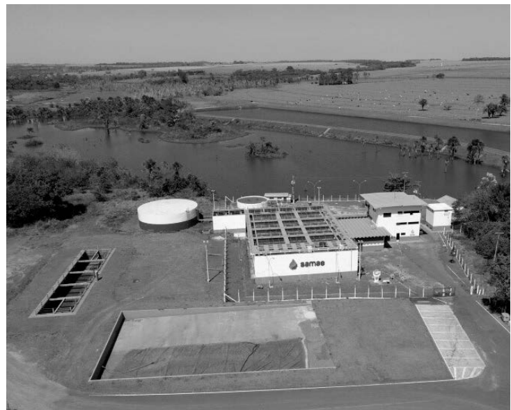
Foto recente da Estação de Tratamento de Água
