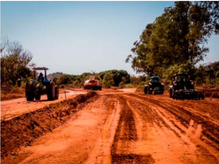
Restante da rodovia MT-020 sendo pavimentado
