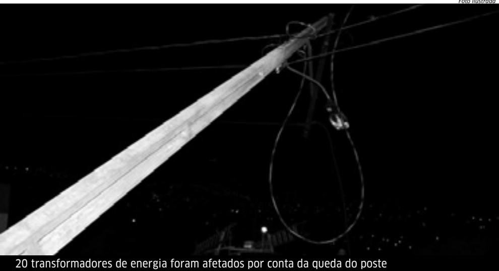
20 transformadores de energia foram afetados por conta da queda do poste
