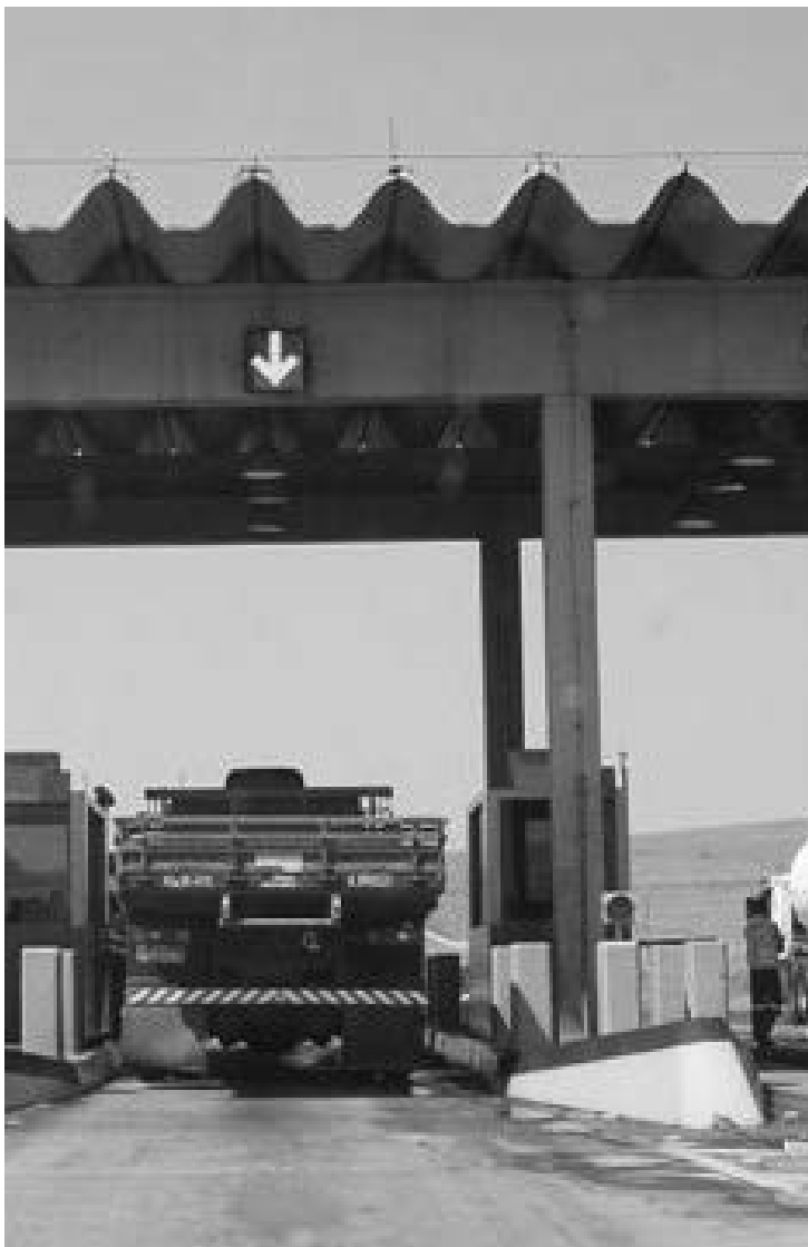
A concessão visa à melhoria das condições das rodovias
