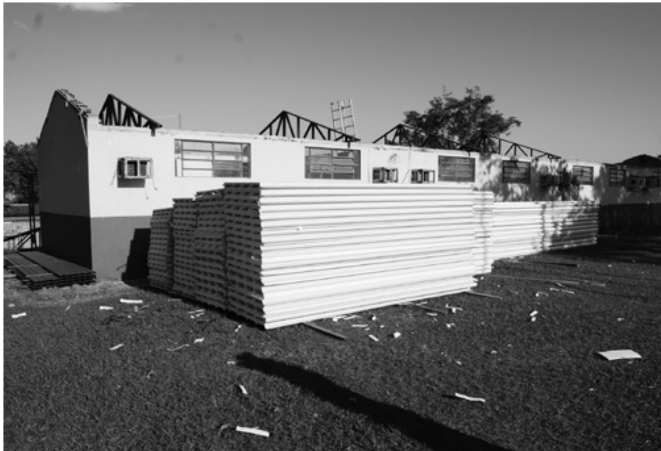
A escola Petrônio Portela no Distrito de São Jorge passa por uma reforma geral e ampliação na estrutura
