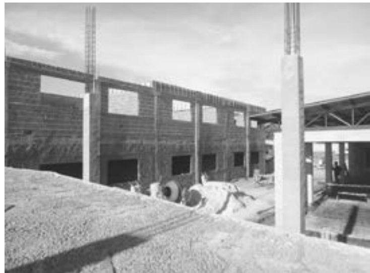
Obras da Escola do Tarumã são umas que ficarão para 2019
