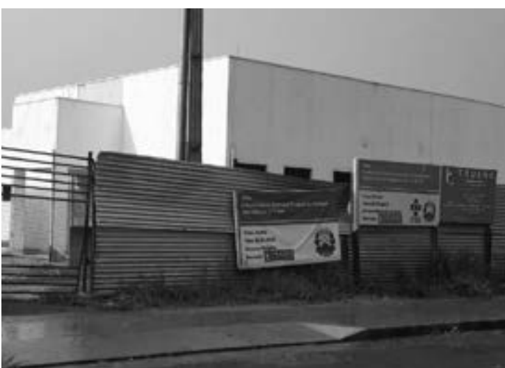
Centro de Reabilitação e Unitan passam por reformas
