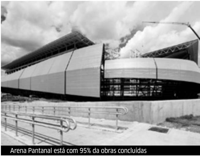
Arena Pantanal está com 95% das obras concluídas
