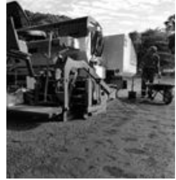
Pavimentação de vias
