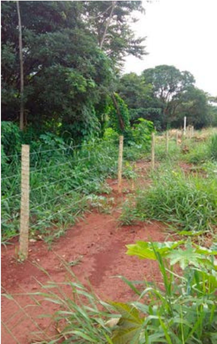
Cercamento de Córregos está acontecendo
