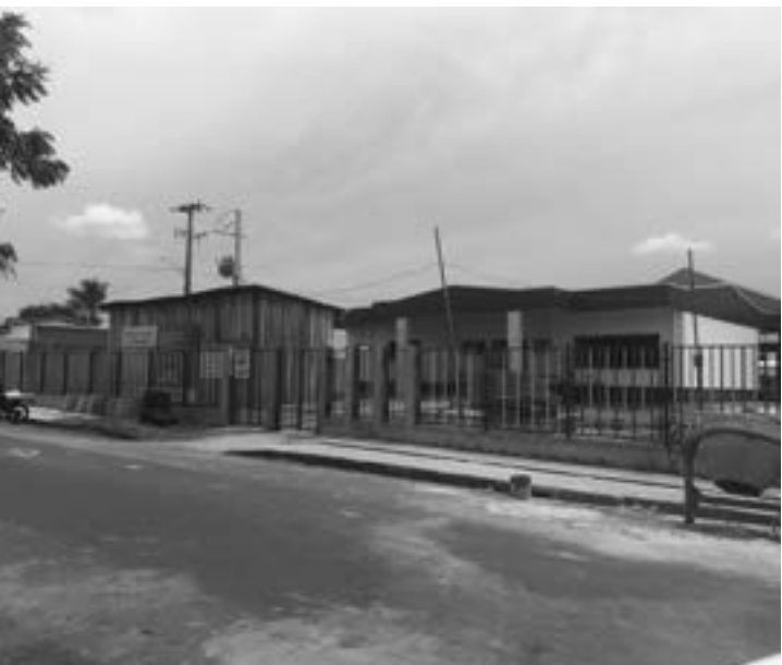
As obras já estão 99% concluídas
