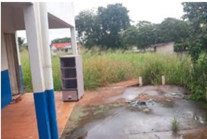
Local hoje apresenta apenas degradação, abandono e medo
