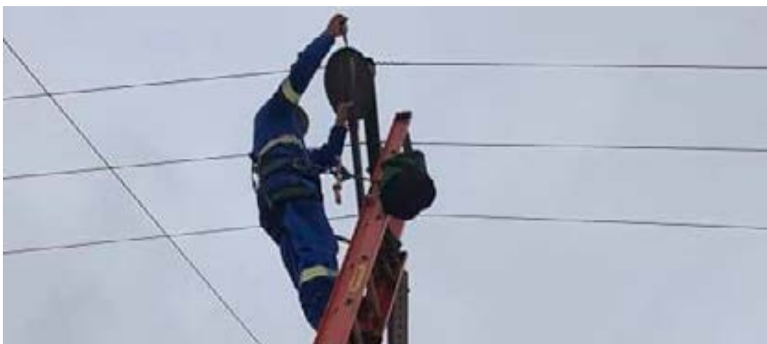
Município realiza manutenção das lâmpadas
