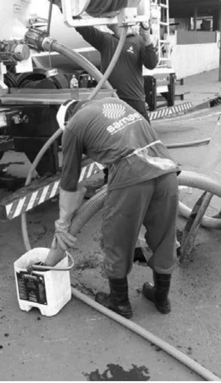
Trabalho é realizado na Rua 01
