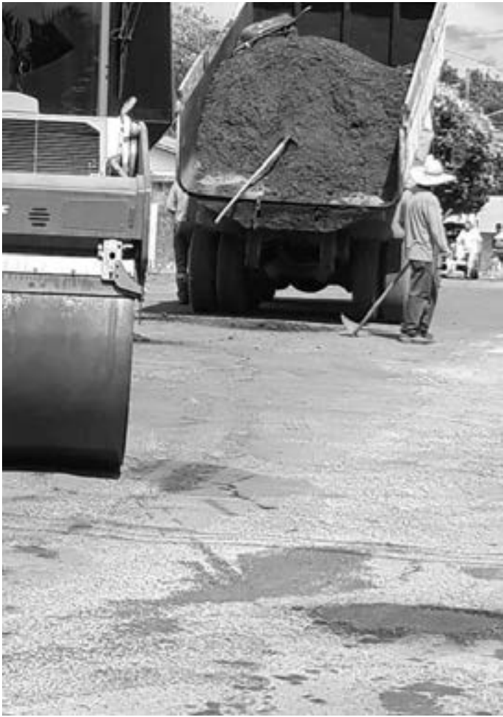
Serviço foi realizado no bairro Shangri-lá
