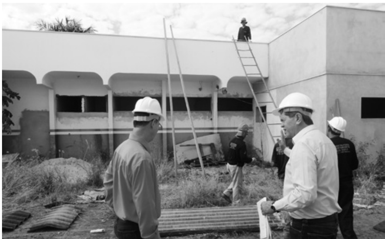
Prefeito visitou as instalações e conferiu reinício dos trabalhos
