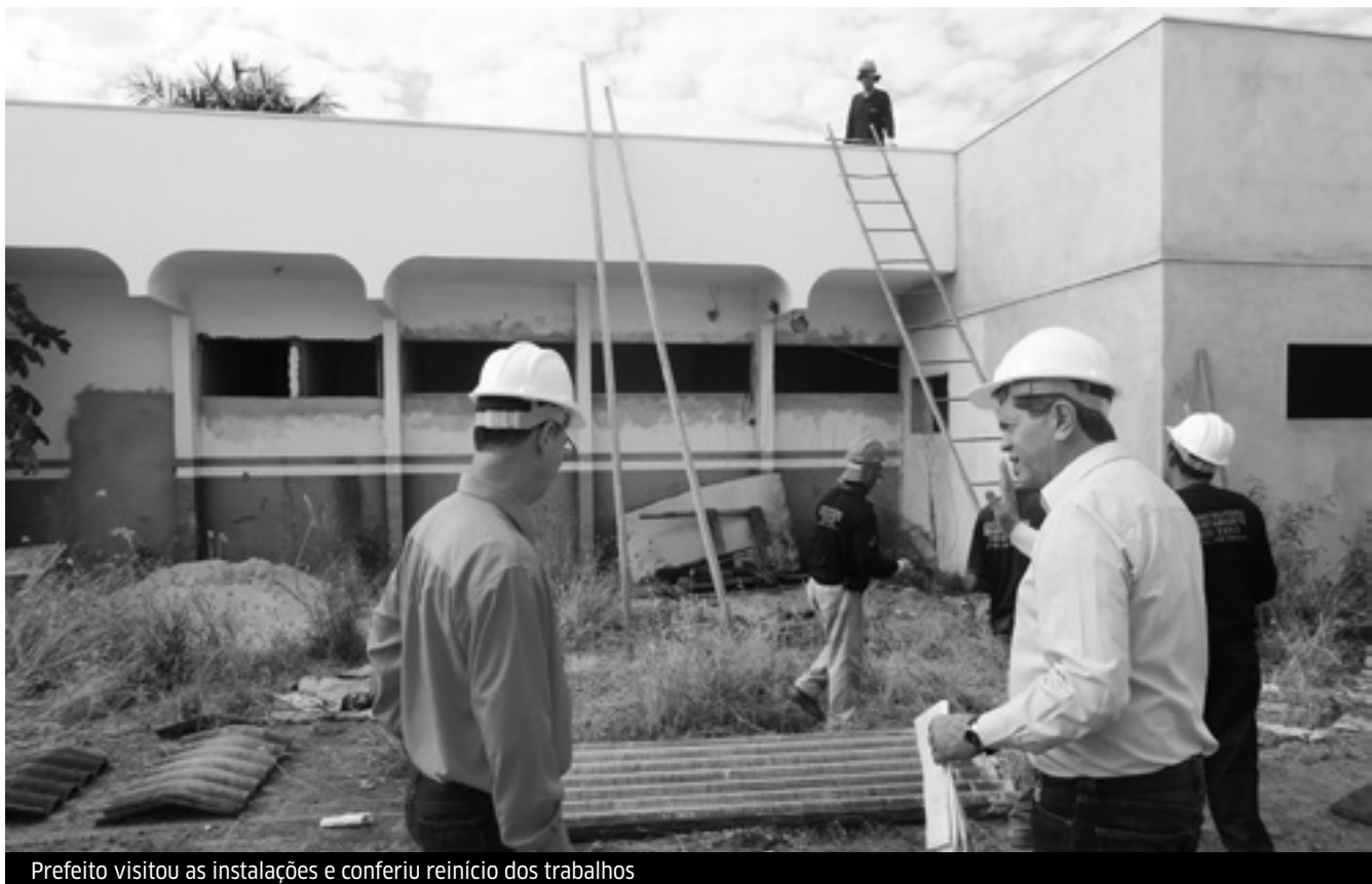
Prefeito visitou as instalações e conferiu reinício dos trabalhos
