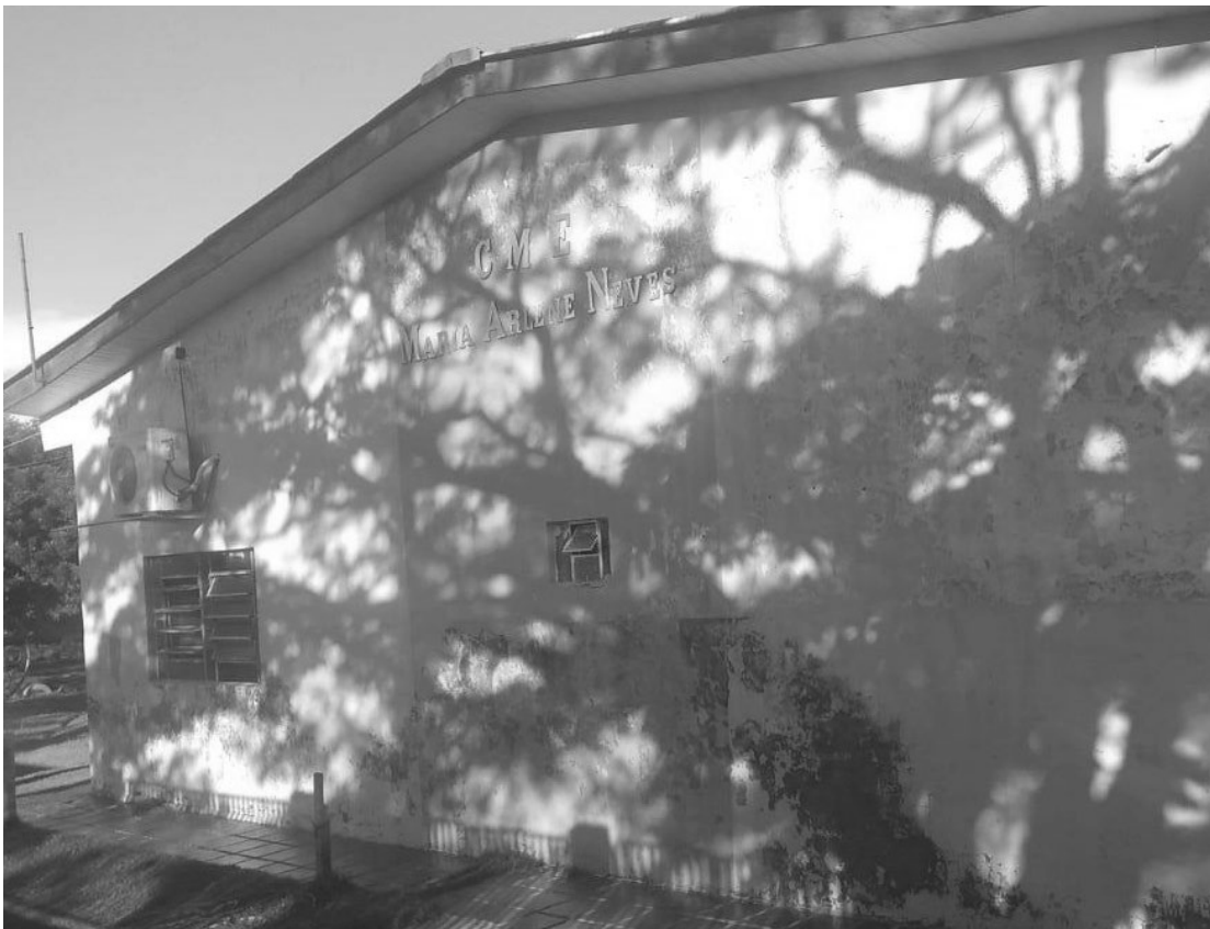
Escola está em condições insalubres
