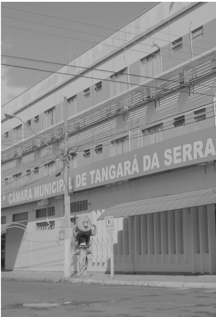
Prédio não tem alvará de combate a incêndio
