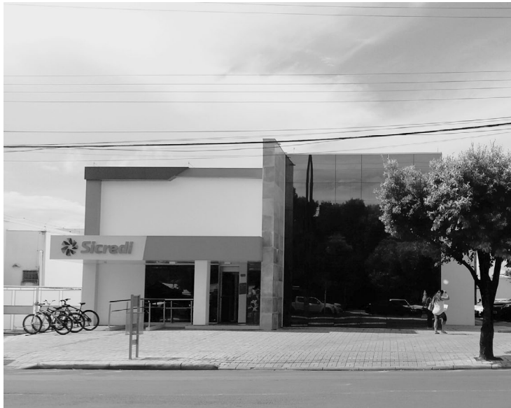
Agência Avenida Tancredo Neves
