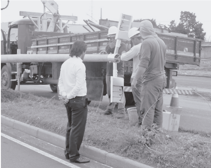
Obras estão em fase de acabamento
