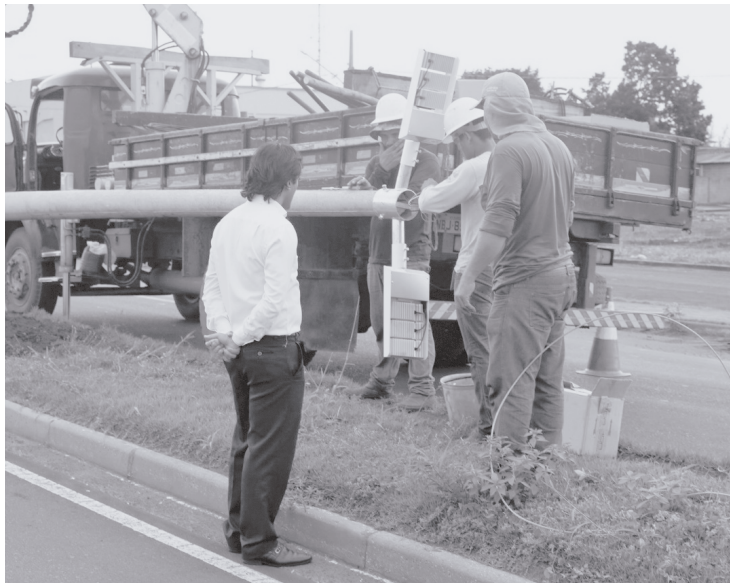
Obras estão em fase de acabamento
