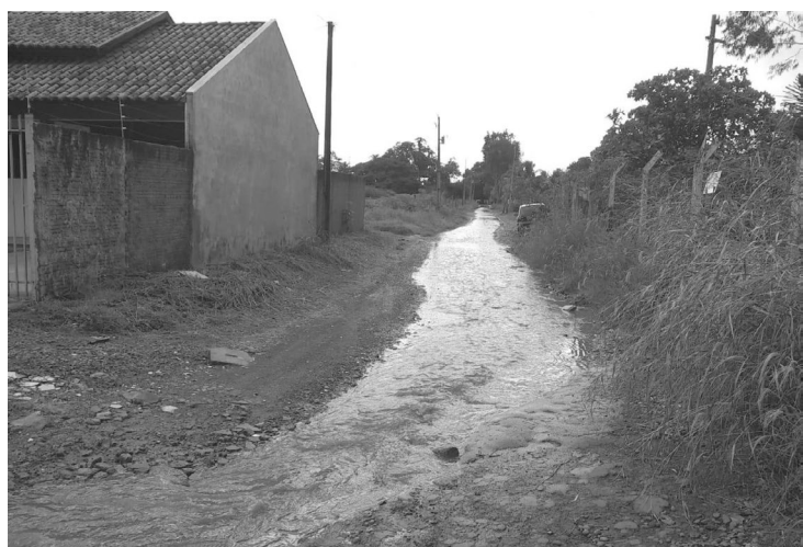
Estrada está em situação precária
