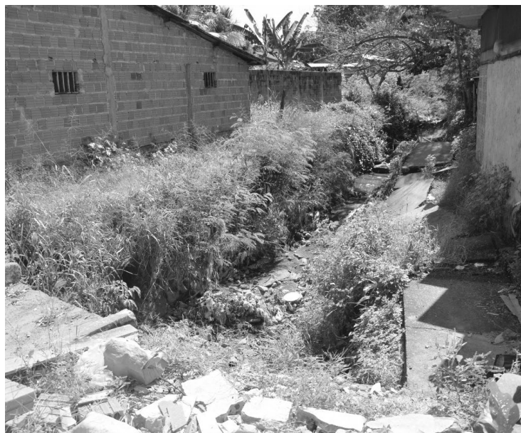
Residências muito próximas do canal
