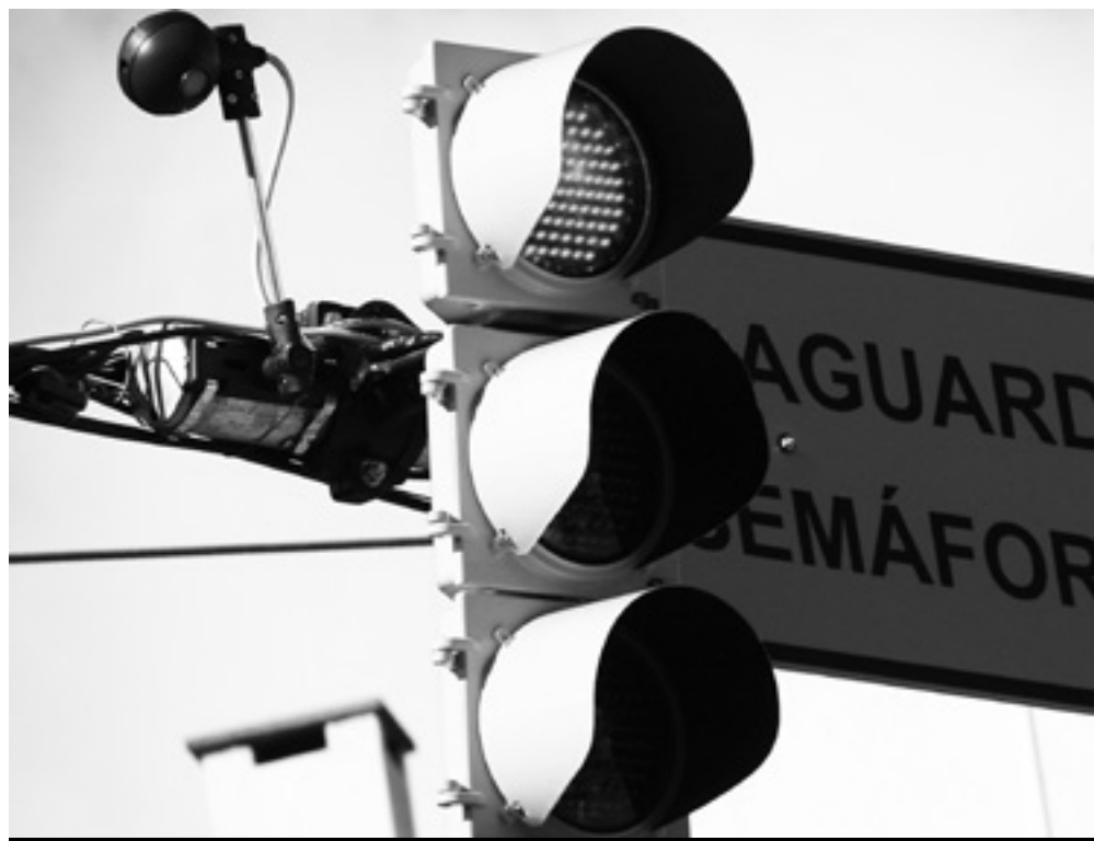
Os conjuntos semafóricos serão instalados em cinco diferentes pontos de cruzamentos
