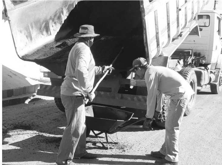
Trabalhos de fechamentos seguem na avenida
