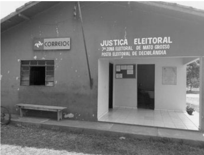
O posto em Deciolândia está instalado em prédio próprio
