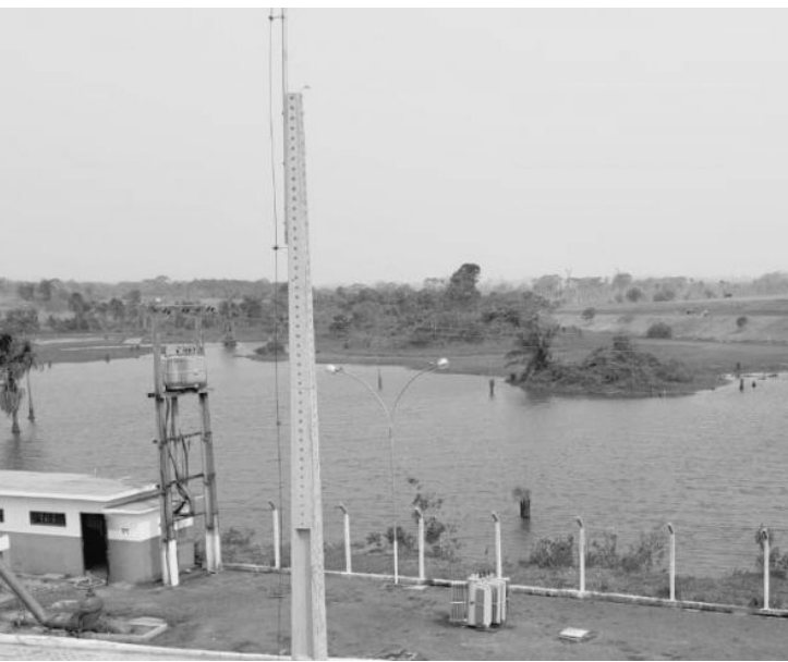
Reservatórios em estado crítico
