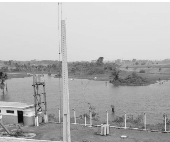
Reservatórios em estado crítico
