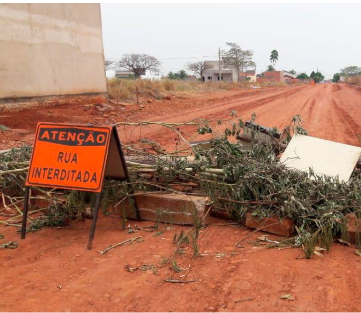
Trecho está interditado
