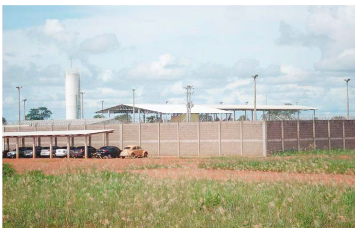
CDP está localizado no Jardim Industriário
