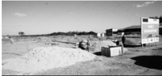
A obra orçada em R$ 453.404,70
