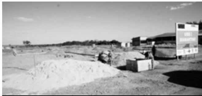
A obra orçada em R$ 453.404,70
